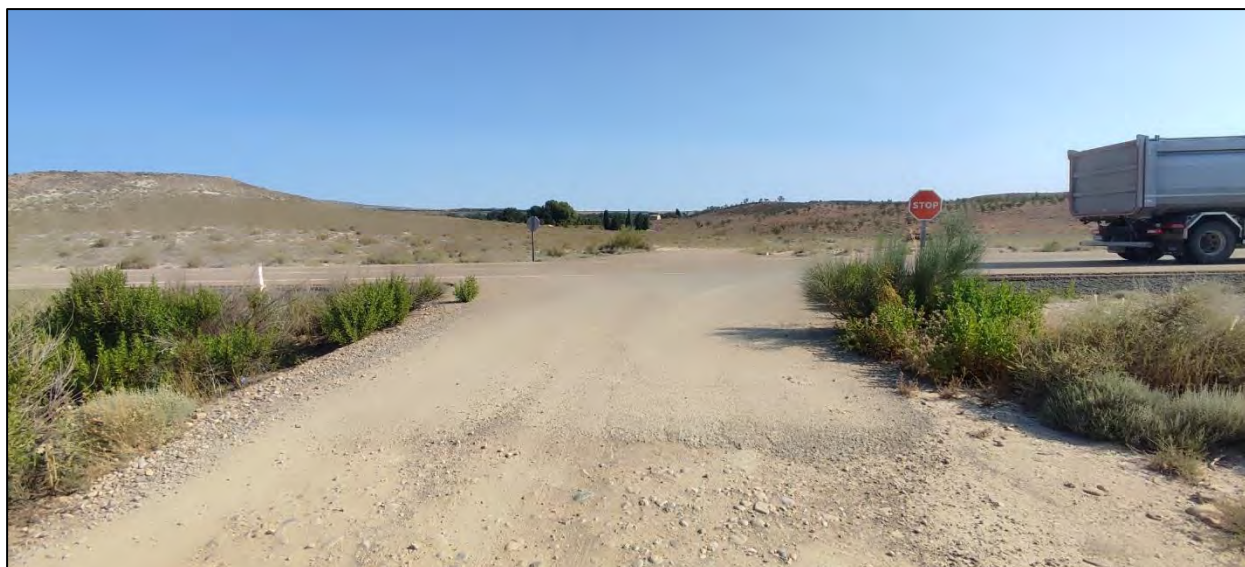
Fotografía 3: Punto de conexión entre futura la calle de acceso al sector y la variante V235-Z (A-122).
