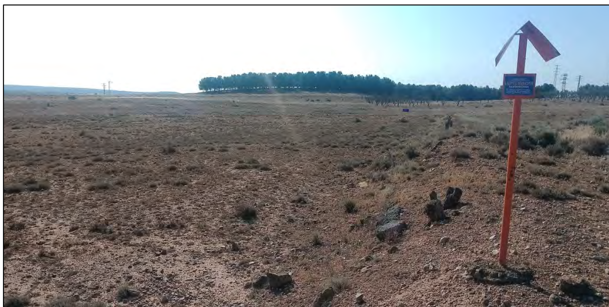
Fotografía 17: Gasoducto que atraviesa el Sector SUZ-ND-05.1.
